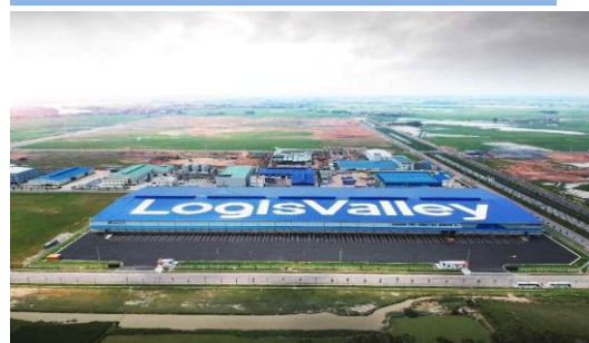
越南 LogisValley北宁1仓库
