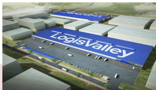
越南LogisValley北宁2仓库
